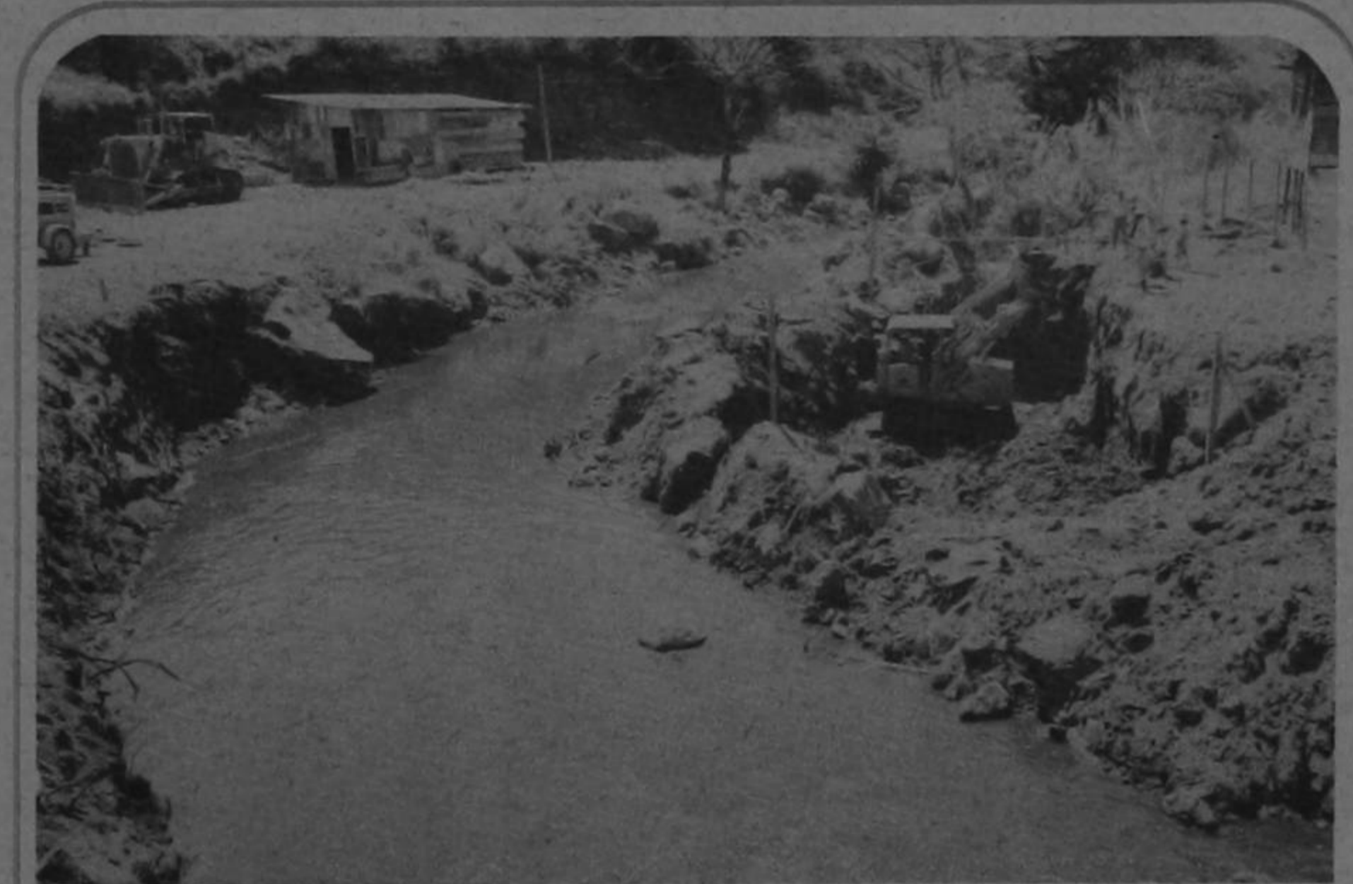
En una intensa labor dentro del cauce de algunos ríos al sur de San José, maquinaria pesada municipal abre canales para evitar los desbordamientos de invierno y rectifica los cauces de los ríos. Se trata de ganar una batalla al agua violenta de las lluvias.
